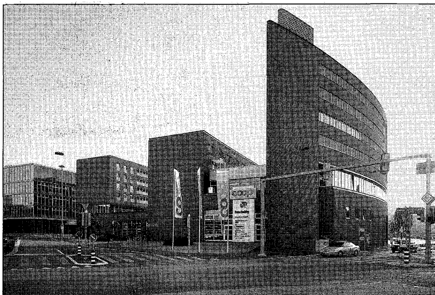
Im 1,9 Mrd. Fr. schweren Liegenschaftenportefeuille der Allreal: Wohn- und Geschäftsüberbauung Center Eleven in Zürich-Oerlikon.
